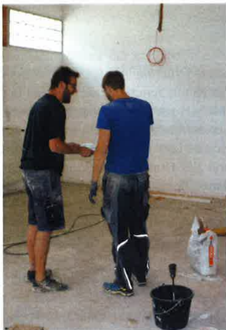
Großbaustelle im Leseraum der Provinzbibliothek Innsbruck
